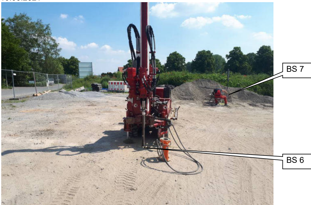
Foto 6: Blickrichtung ~ O; Bereich der BS 6 und BS 7 (Markierungen)
