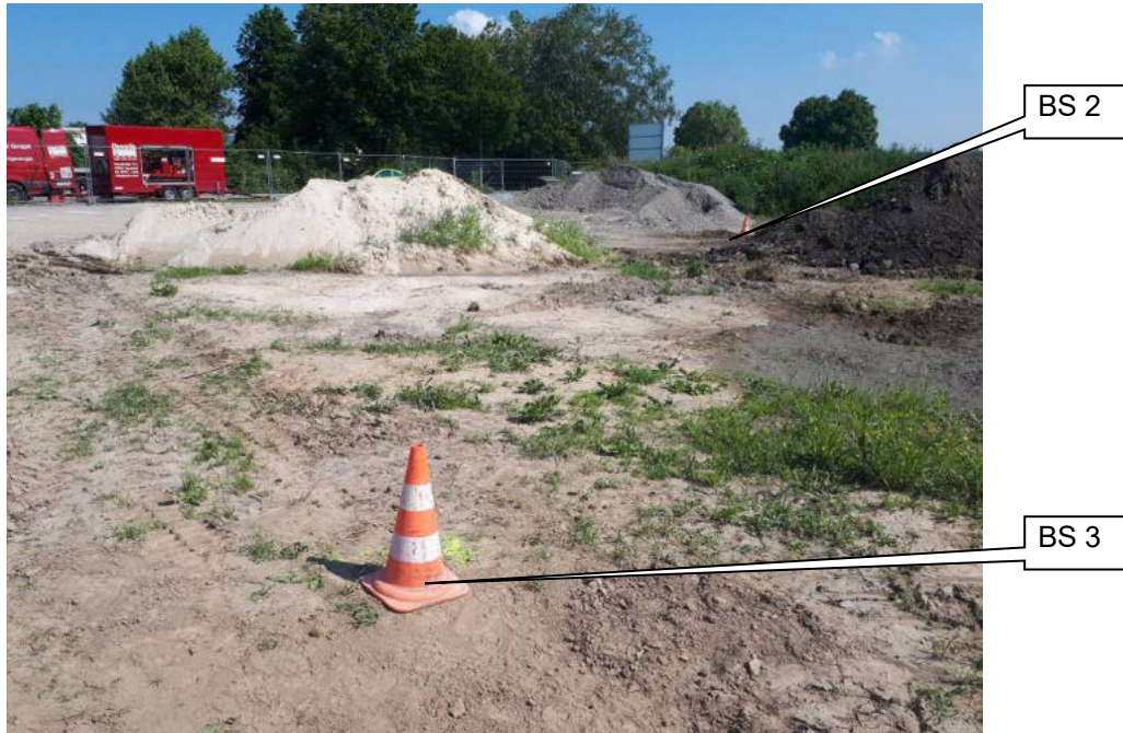
Foto 3: Blickrichtung ~ NO; Bereich der BS 2 und BS 3 (Markierungen)
