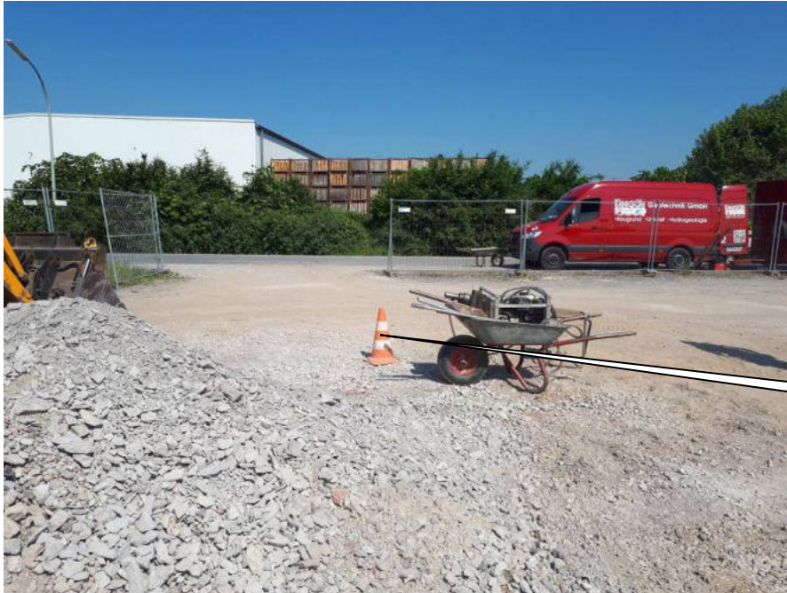
Foto 1: Blickrichtung ~ N; Bereich der BS 1 (Markierung)
